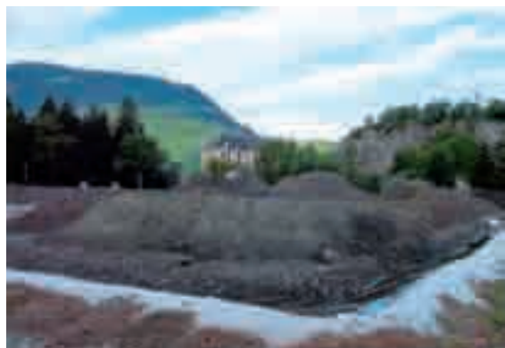
Vizille [38] : Excavation par passes successives suite à un diagnostic approfondi du site pour la réalisation d'une salle polyvalente pour la mairie de Vizille. Criblage des matériaux, puis traitement des terres polluées aux hydrocarbures sur plateforme étanche avec réalisation d'un bassin de récupération des eaux de pluie. Volume traité : environ 1 500 m 3 (Gauthy).
