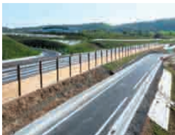
Ecran anti-bruit au Pont des Nautes sur l'A714 (Allier).
