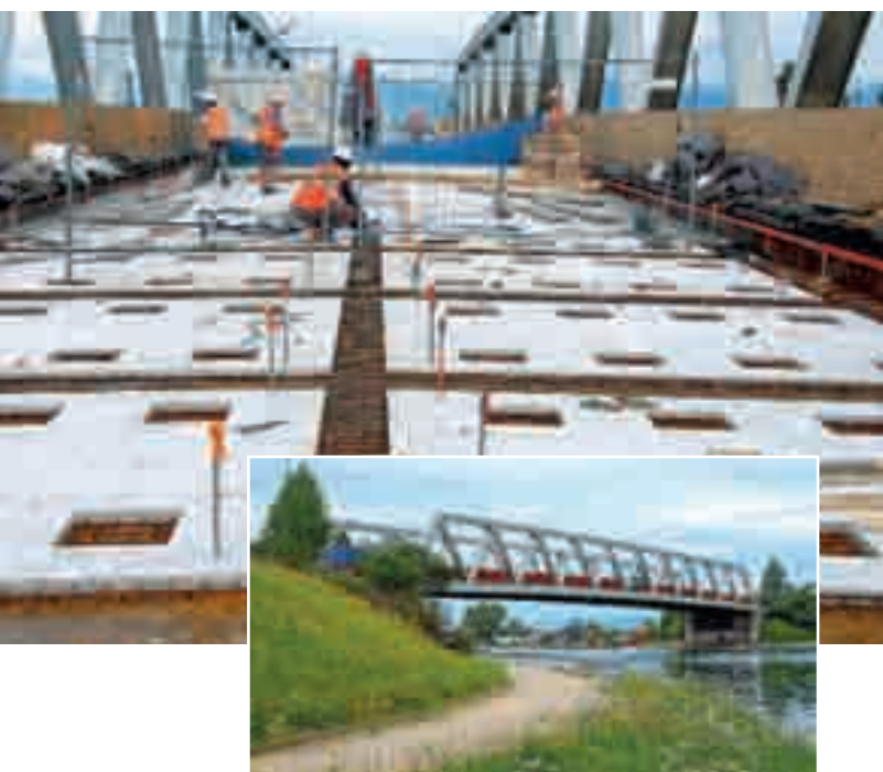
Mise en œuvre du procédé Orthodalle pour la rénovation du pont d'Illzach [68](Eiffage Travaux Publics).
