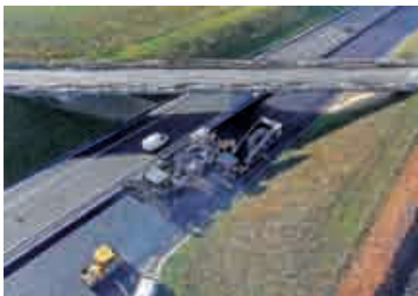
Pose de la Grave bitume GB5® sur le chantier de l'A49 (Eiffage Travaux Publics – APRR).
