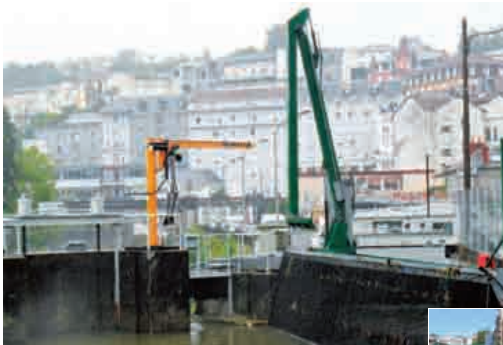
Dégrilleur à dévalaison (Eiffage Industrie – Prix spécial Biodiversité aux Trophées de l'Innovation 2011). La centrale hydroélectrique des Sanctuaires de Lourdes est équipée d'un dégrilleur unique en France. Le dispositif permet de capter automatiquement et régulièrement tous les déchets qui se trouvent dans l'eau tout en sécurisant et facilitant le cheminement des anguilles et jeunes saumons qui dévalent le Gave pendant leur migration. Pour ce faire, l'espace entre les barreaux des plans de grilles a été considérablement réduit et des bassins de dévalaison ont été installés.
