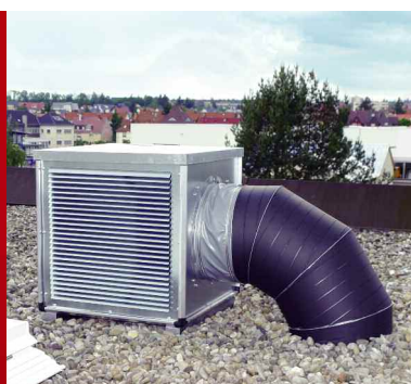
Installation sur toit avec toiture et grille pare-pluie (acc).
