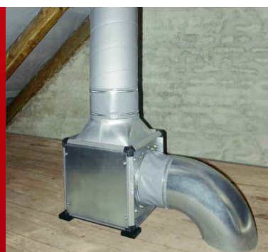
Installation en combles avec plots antivibratoires (acc).
