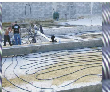
Pose des capteurs géothermiques d'un puits canadien à eau glycolée.
