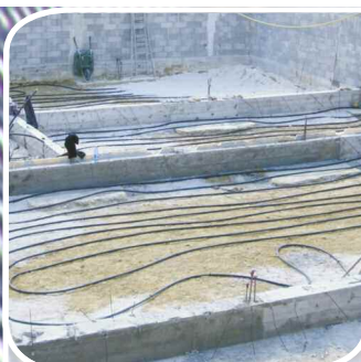
Pose des capteurs géothermiques d'un puits canadien à eau glycolée.
