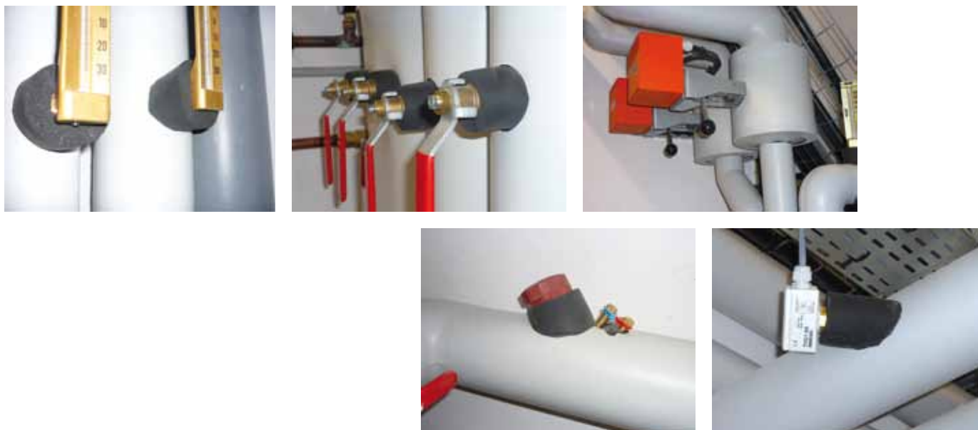
Figure 30 : INSTALLATIONS DE L'OPÉRATION B2-1700M 2 -BEPOS-38 CORRECTEMENT CALORIFUGÉES - source ENERTECH
