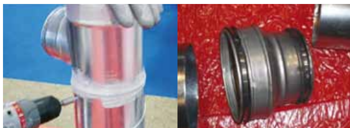
Figure 63 : LIAISONS AVEC MASTIC (à gauche) ET ACCESSOIRE À JOINT (à droite) - source : Etamine
